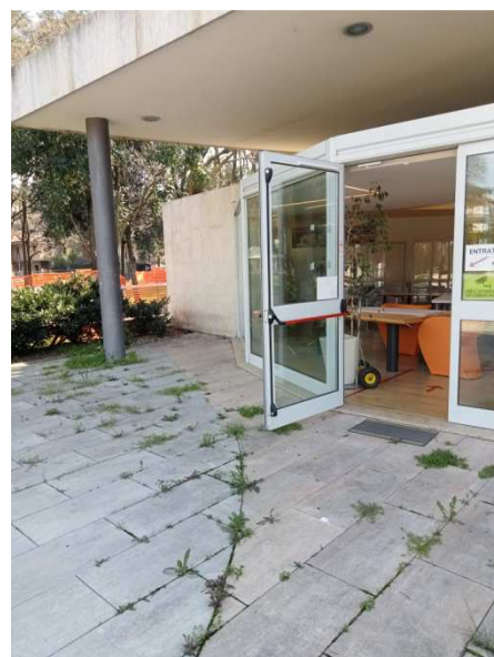
Vetrata con ingresso al Bar dal Parco
