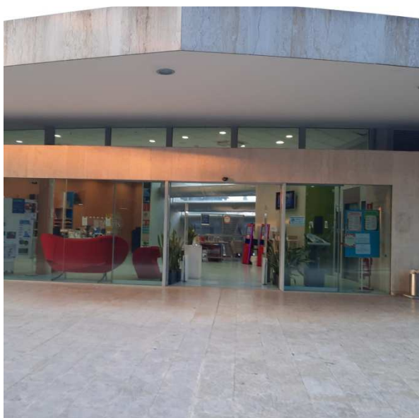
Vetrata con porta di ingresso all'Atrio e Biblioteca
